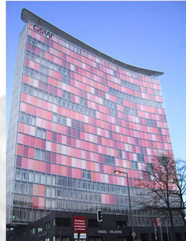
Ουρανοξύστης GSW , Βερολίνο 1999 αρχιτέκτονες: Matthias Sauerbruch , Louisa Hutton.
