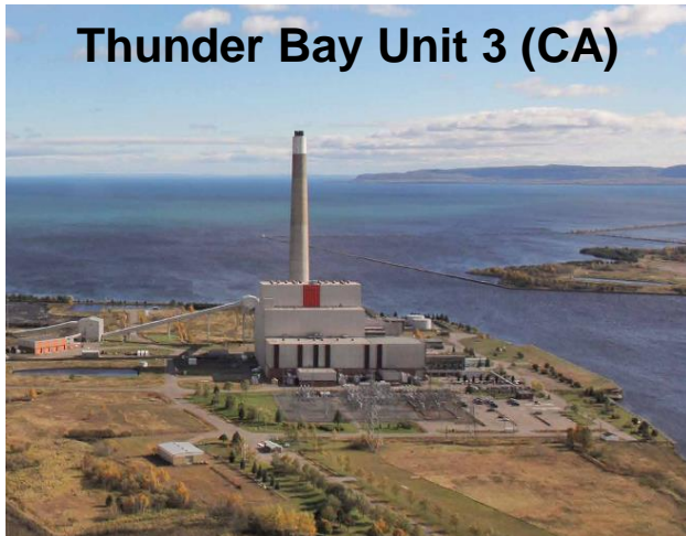
Πρώτη 100 % μετασκευή με Arbaflame (steam exploded) πελλέτες ξύλου. Εμπορική λειτουργία 2015. Κόστος μετασκευής ~ 30 €/kW e
